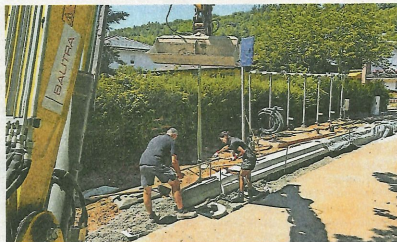
Derzeit arbeitet Mara Schwarz auf einer Baustelle in Kaiserslautern. Seit ein paar Wochen ist sie Gesellin im Berufsfeld Straßenbau.
